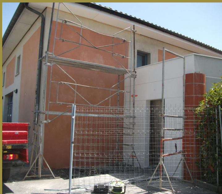
Travaux à la salle polyvalente suite à un sinistre causé par l'embrasement d'un conteneur.
