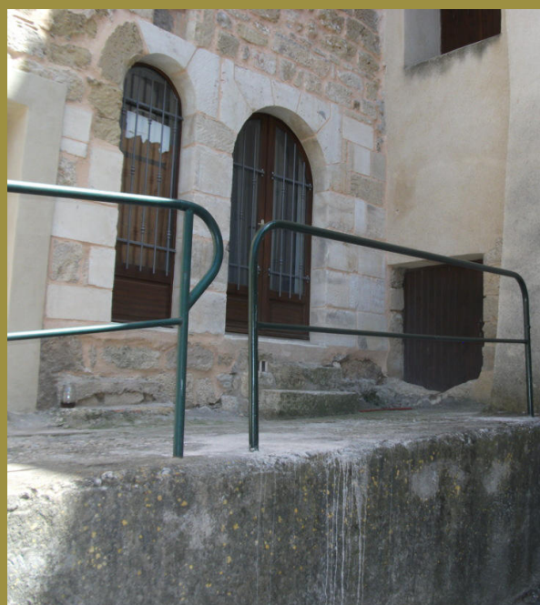
Pose de garde-corps à la Placette.
