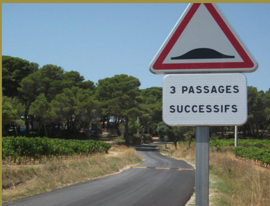
Sécurisation des abords du camping de la Pinède.
